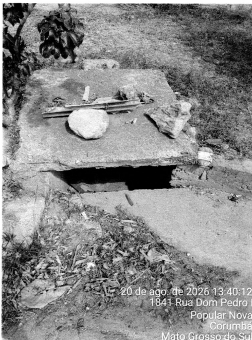
Foto 01 – boca de lobo, Rua Luiz Feitosa Rodrigues esquina com Rua Dom Pedro I – dispositivo em bom estado de conservação, necessitando de limpeza, já executada. A abertura da boca é avantajada devido ao grande volume de água a ser captado no local.
