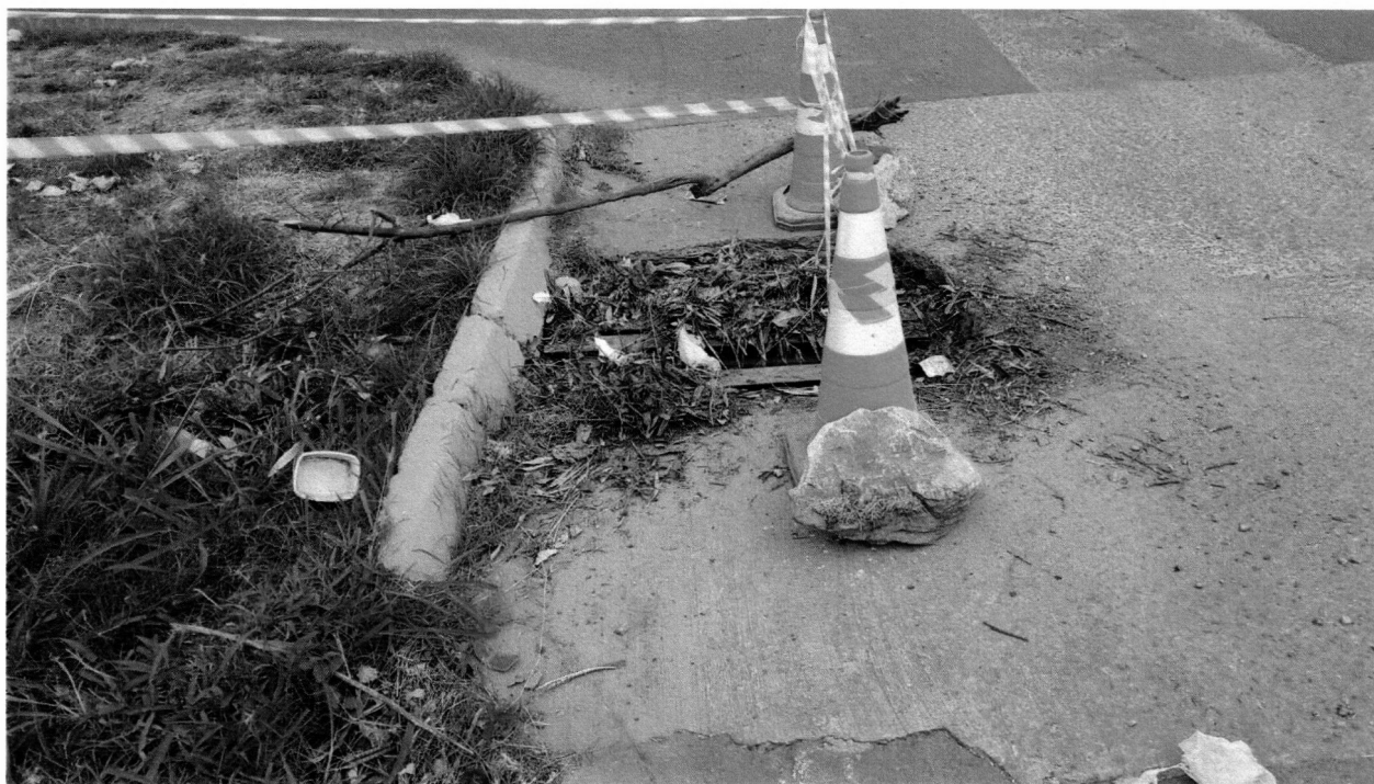
Foto 04 – boca de lobo, Rua Luiz Feitosa Rodrigues esquina com Rua Dom Pedro II – dispositivo antigo sem uma das peças de trilho. Manutenção em execução com sinalização já executada.
