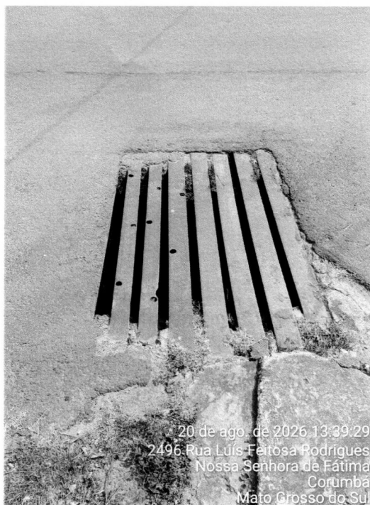
Foto 03 – Caixa de passagem, Rua Luiz Feitosa Rodrigues esquina com Rua Dom Pedro I – dispositivo em perfeito estado de conservação, necessitando de limpeza, já executada.
