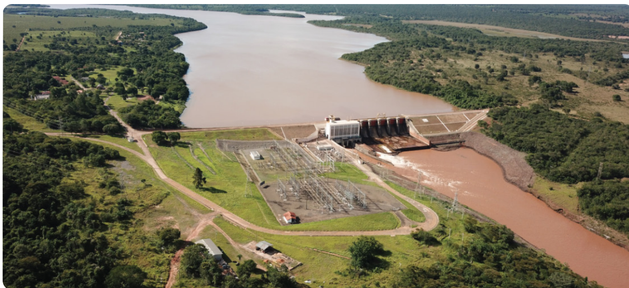
Usina Hidrelétrica Assis Chateaubriand, em Ribas do Rio Pardo.
