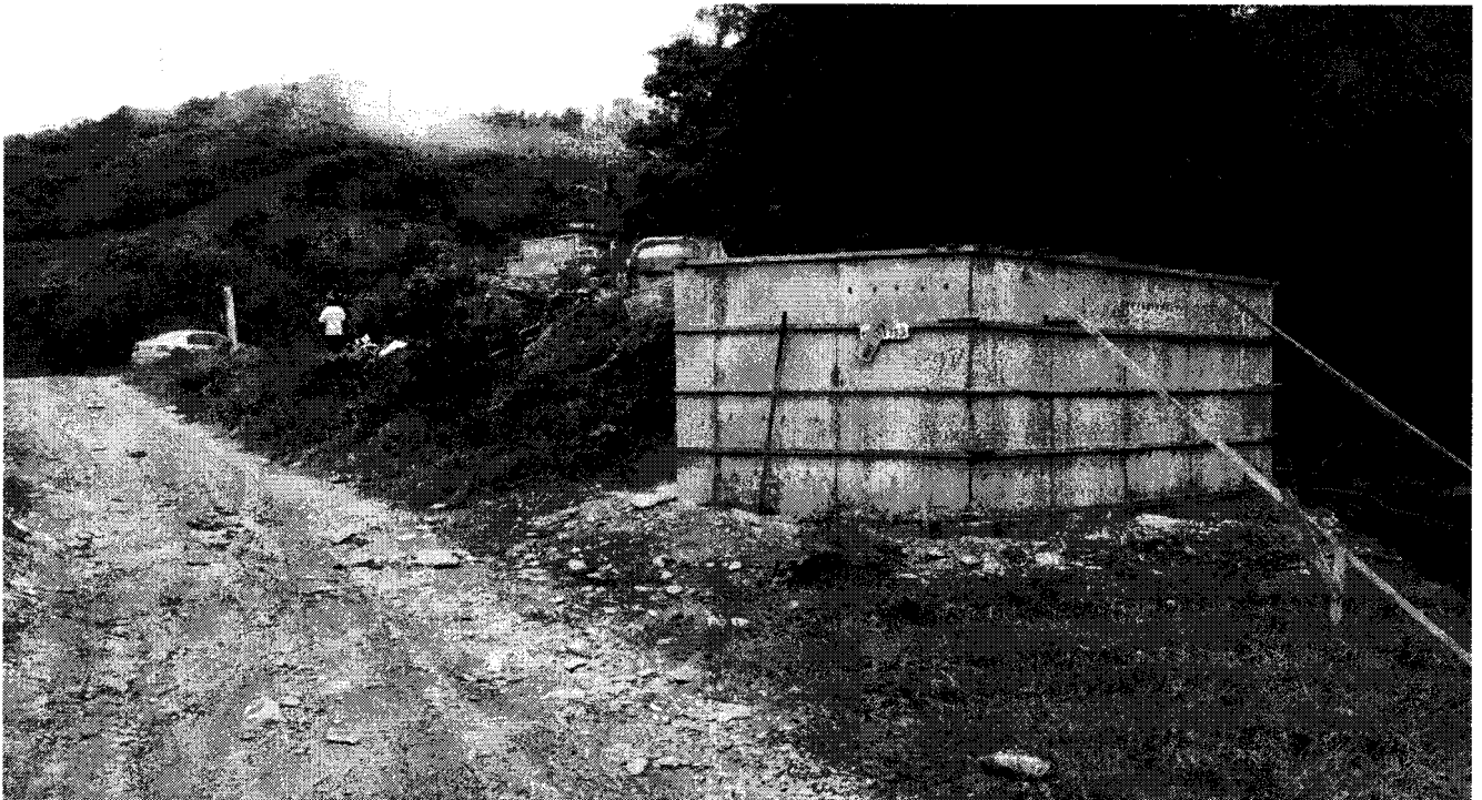
Vista lateral da caixa de concreto da base de apoio.
